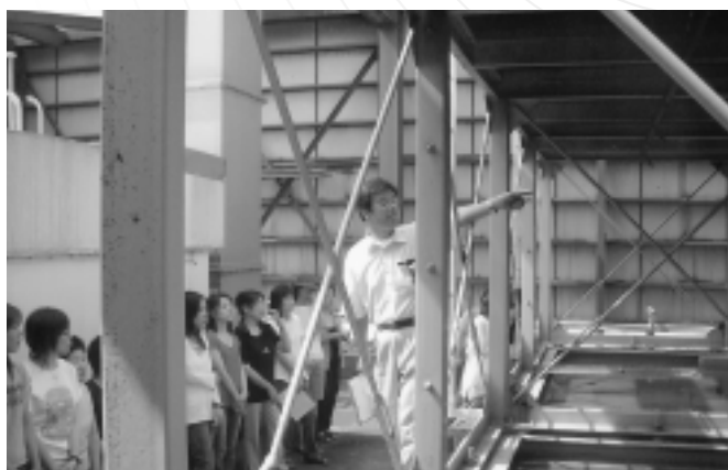
室上の重油タンク・貯水槽の見学
